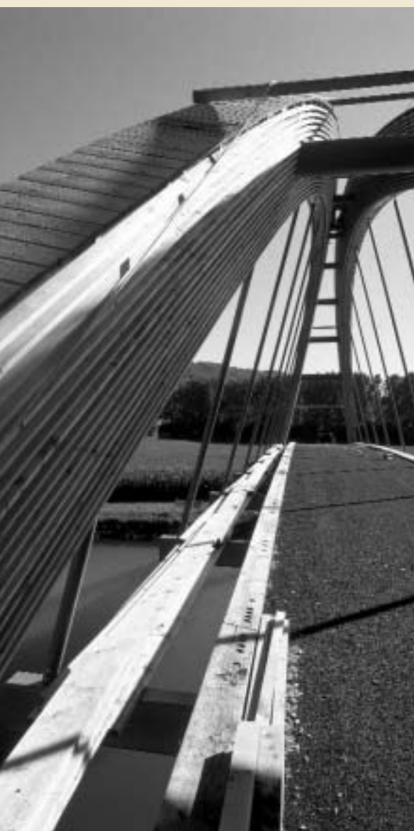
Brücke über die Broye, Murten; Y. André
