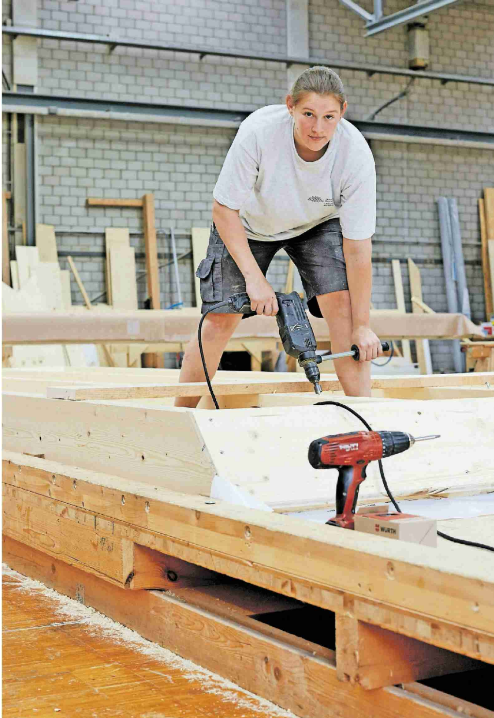
Die Holzelemente werden im Werk fertig montiert und in einem Stück an die Baustelle geliefert: Zimmerin Michèle Pfeifer
