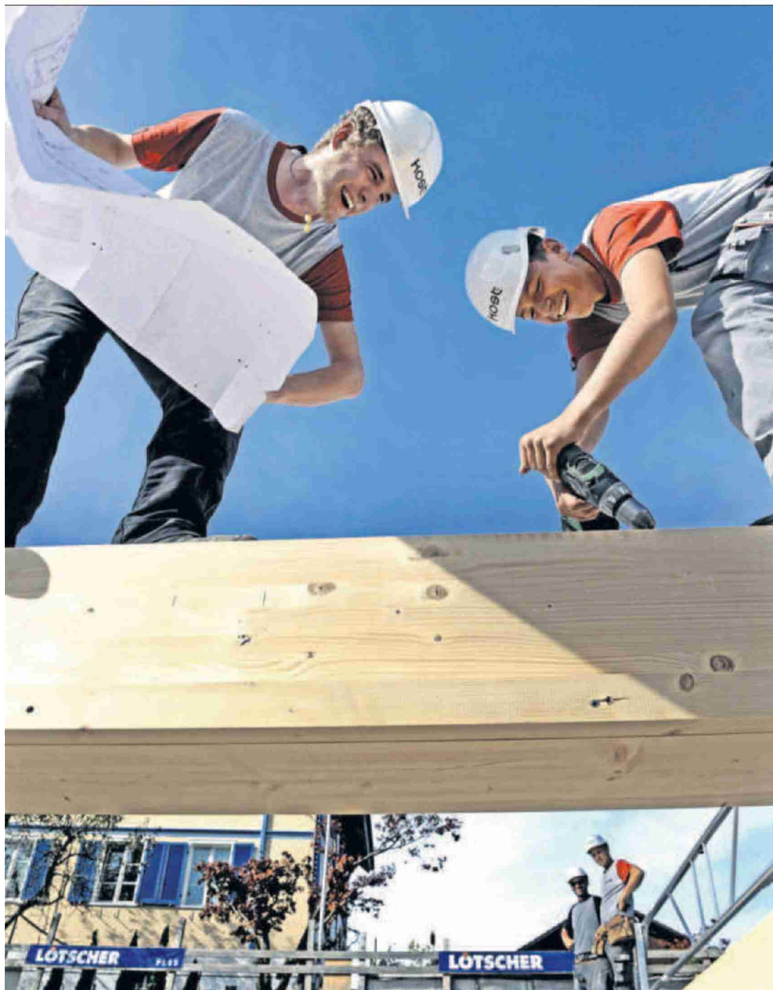
Tobias Bucher (links) und Dominic Durrer machen eine Ausbildung zum Zimmermann bei der Kost AG in Küssnacht am Rigi. Das Bild zeigt sie auf einer Baustelle in Ebikon.
