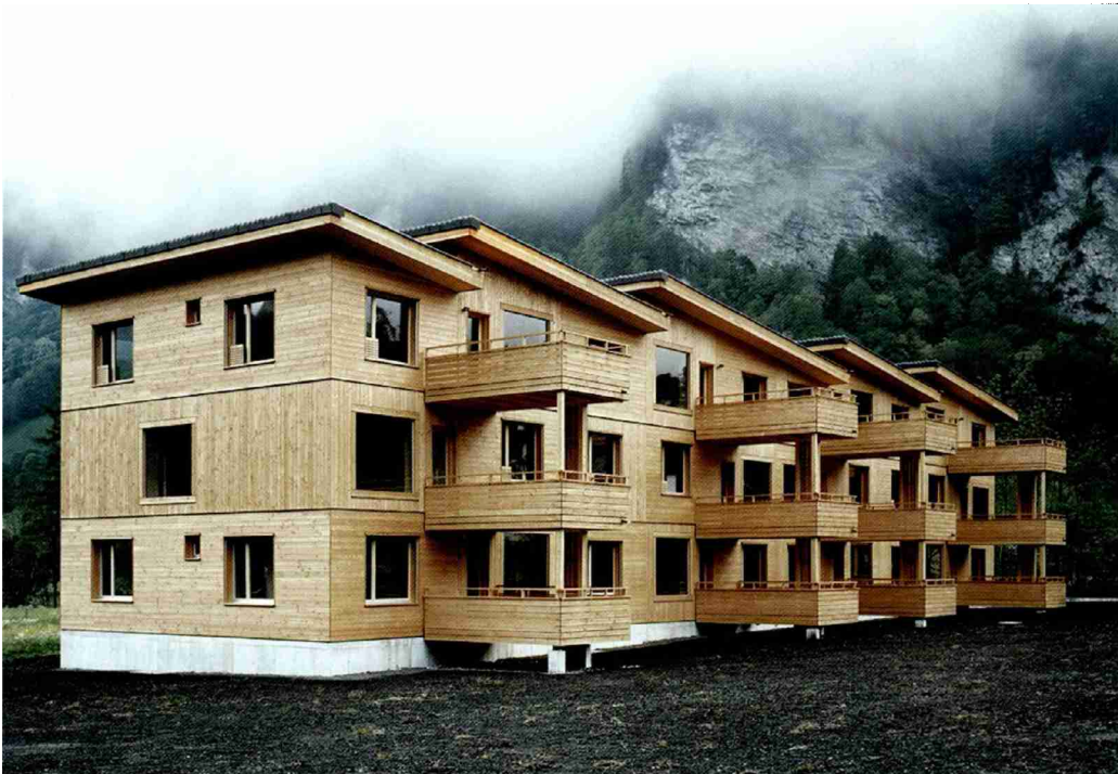
Heutzutage kann man mit Holz auch moderne Gebäude bauen. (Mehrfamilienhaus Müstl, Elm – Foto: Rasmus Norlander)
