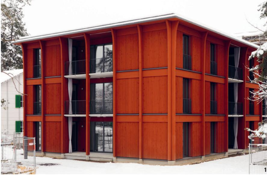
1 Mehrfamilienhaus in Riehen: Der Holzmodulbau von Harry Gugger Studio / Erne AG Holzbau umfasst neun Mietwohnungen. Die Fassade ist so gestaltet, dass die Formate der Module ablesbar sind; spielerisch aufgebrochen wird die strenge Struktur durch Fassadenstützen, die am oberen Ende gebogen sind.
