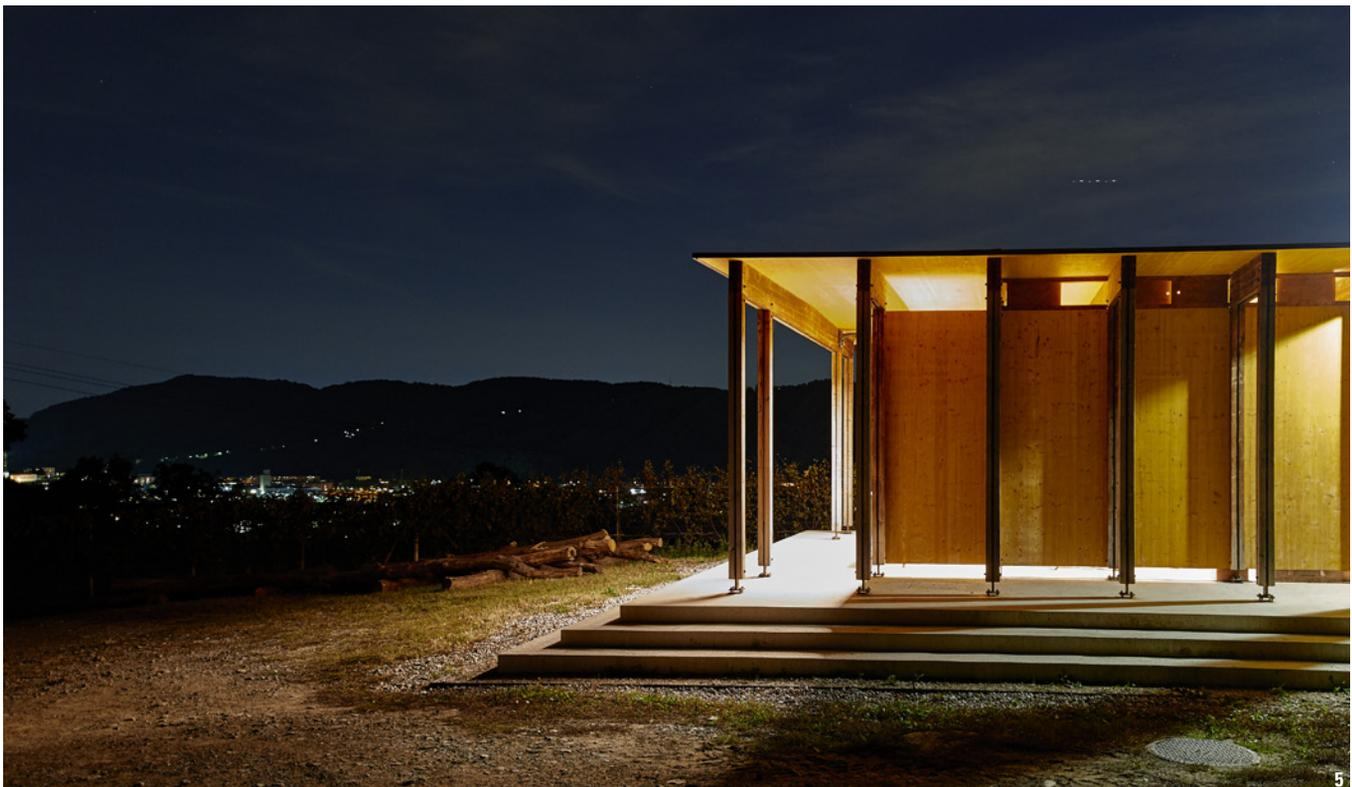
Schweizer Tannenholz bilden zusammen mit 13 Deckenbalken, ebenfalls aus Tannenholz gefertigt, die Tragstruktur des Baus. Die Stützen, deren Abstand jeweils 130 Zentimeter beträgt, weisen eine Kantenlänge von 14 auf 14 Zentimetern auf. Pro Stütze sind jeweils zwei gegenüberliegende Seiten mit einer vertikalen, zwei Zentimeter breiten Nut versehen, was die Bauteile noch schlanker erscheinen lässt. Die 39 auf 14 Zentimeter grossen, aufliegenden Balken überspannen das Gebäude mit knapp acht Metern.
