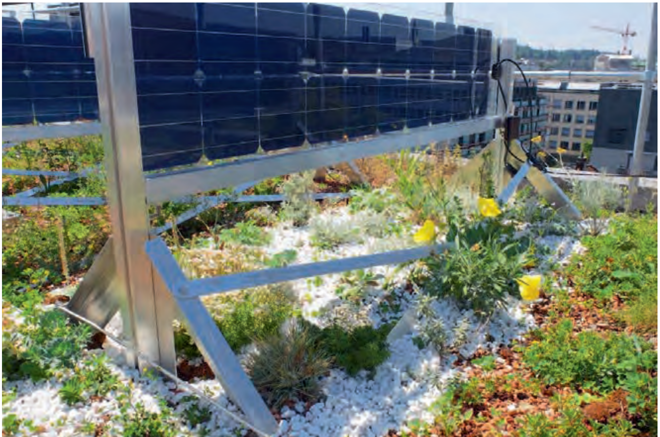
Abbildung 18: Testanlage der ZHAW, Quelle: Solarspar
