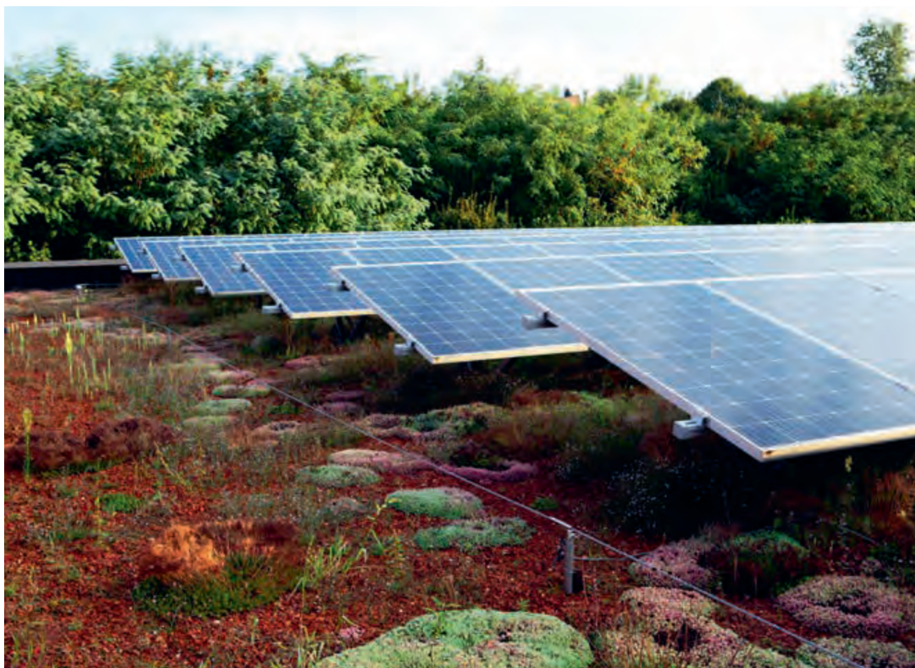
Abbildung 1: PV-Anlage kombiniert mit Extensivbegrünung, Quelle: contec
