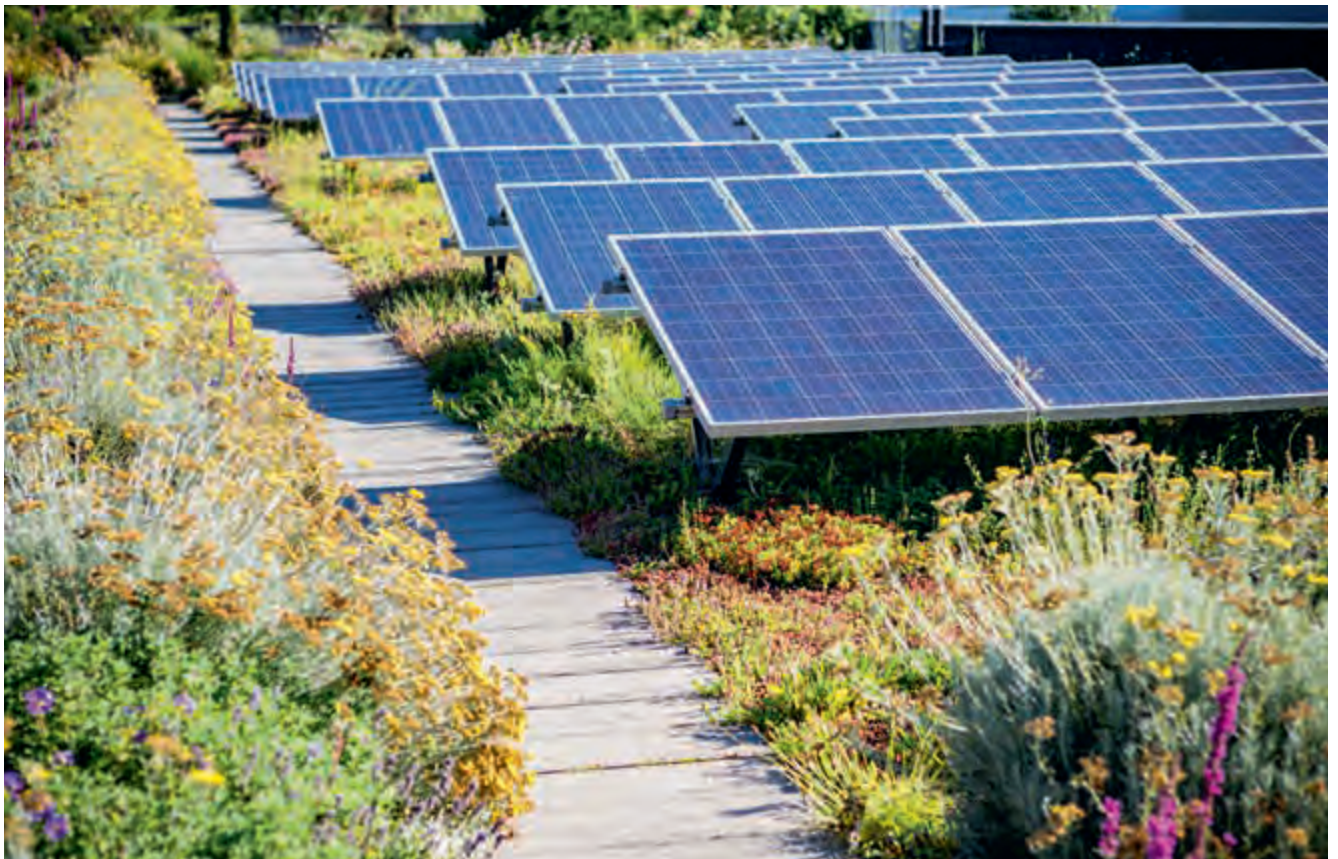
Abbildung 3: Kombination Intensiv-/Extensiv-Dachbegrünung neben PV-Anlage, Quelle: Contec
