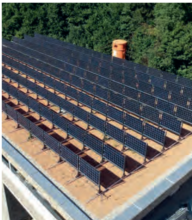
Abbildung 4: Die PV-Anlage soll mit genügend Abstand zum Dachrand hin aufgestellt werden ( \geq 60 cm), Quelle: reech gmbh
