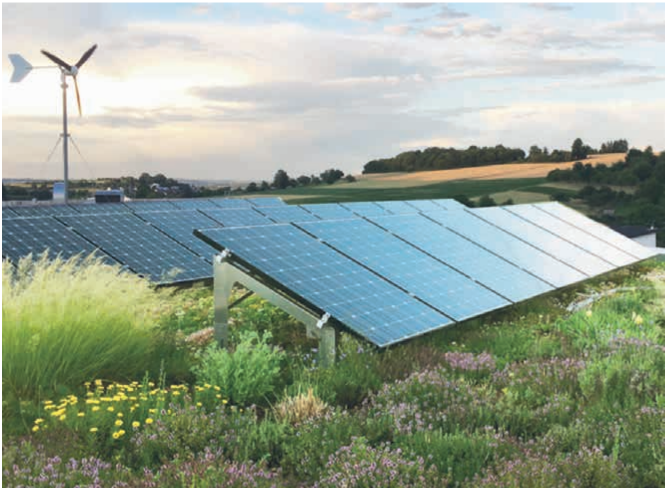
Abbildung 10: Kombination Intensiv-/Extensiv-Dachbegrünung neben PV-Anlage, Quelle: Zinco
