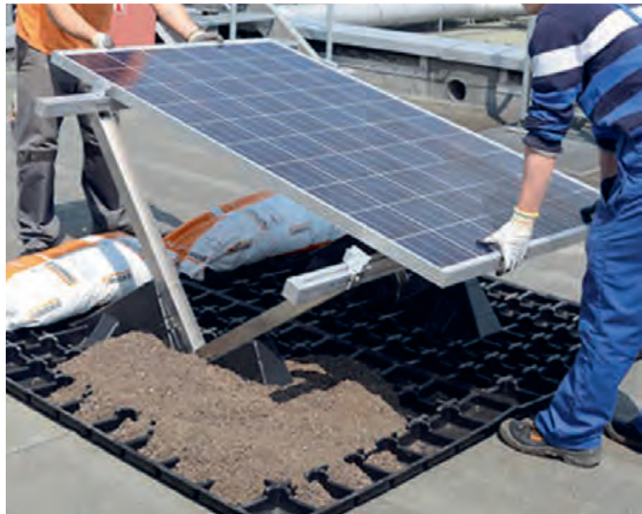
Abbildung 6: Auflastsystem für PV-Aufständerung, Quelle: Bauder
