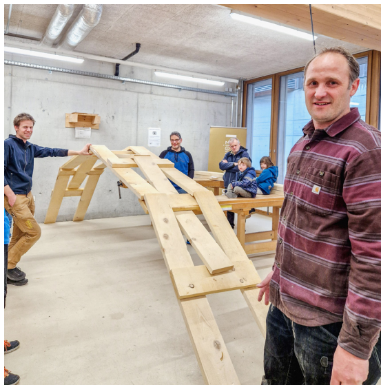
Bau einer selbsttragenden Brücke nach dem Vorbild von Leonardo Da Vinci.
